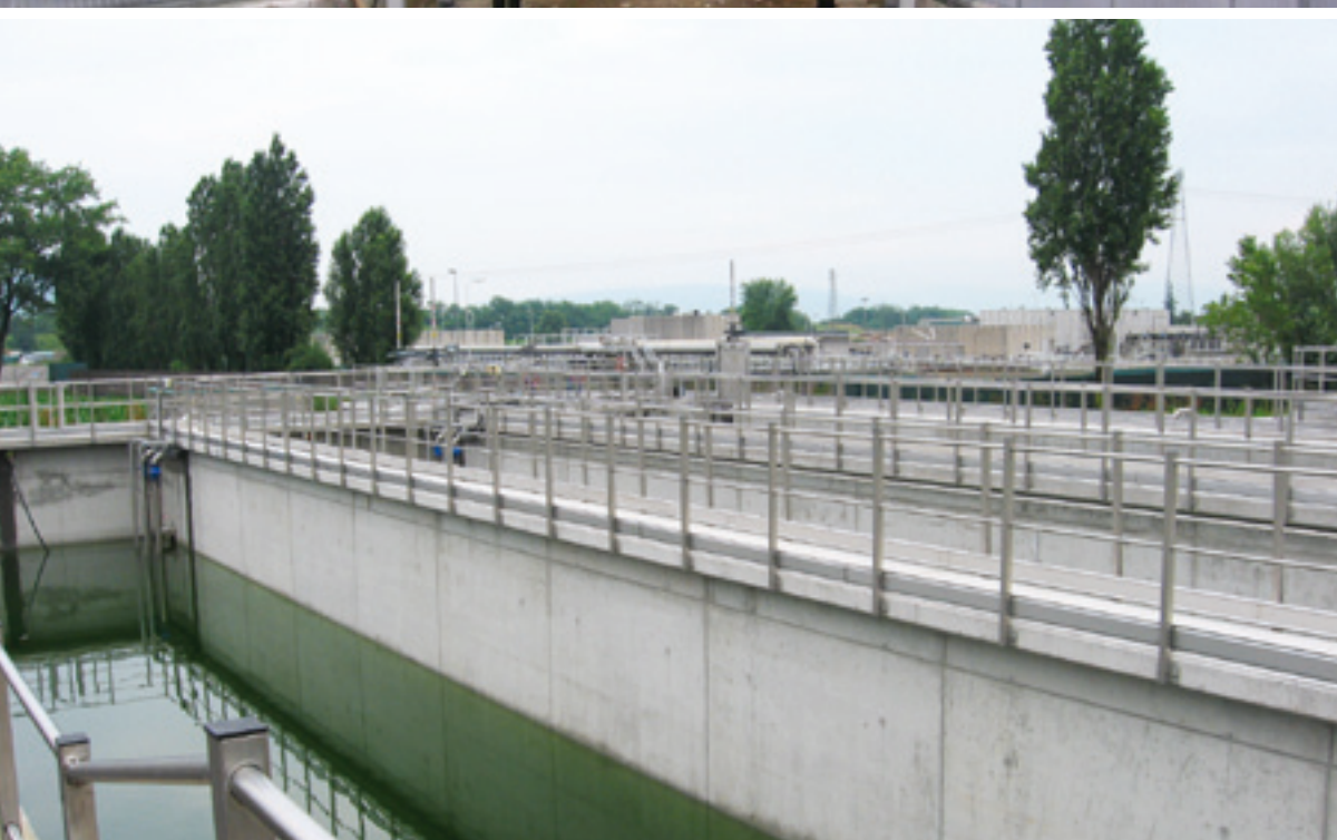
Impianto di trattamento di acque di pioggia – Arzignano (VI)
