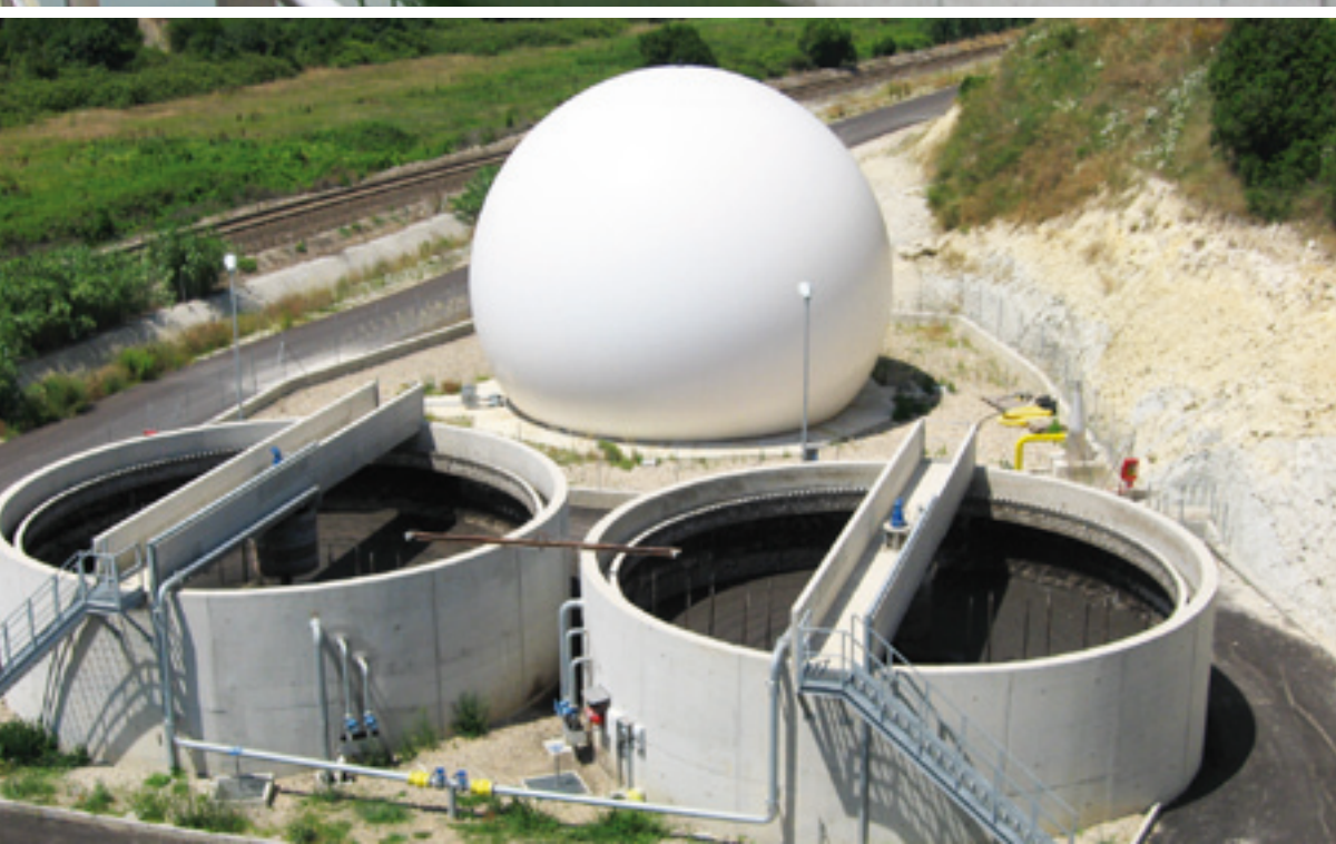
Impianto di trattamento acque reflue civili – Sassari (SS)
