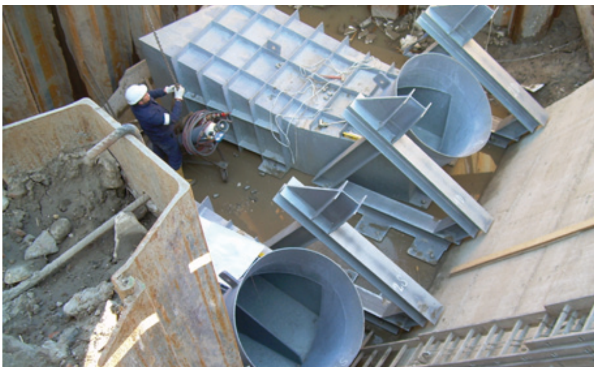
Impianto di sollevamento acque di irrigazione, particolare bocche di aspirazione – Cantonazzo (RO)
